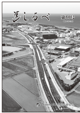
写真：加賀海浜産業道路〔白山市小川町～松本町間 4車線化〕 (写真提供：石川土木総合事務所、編集委員会)
