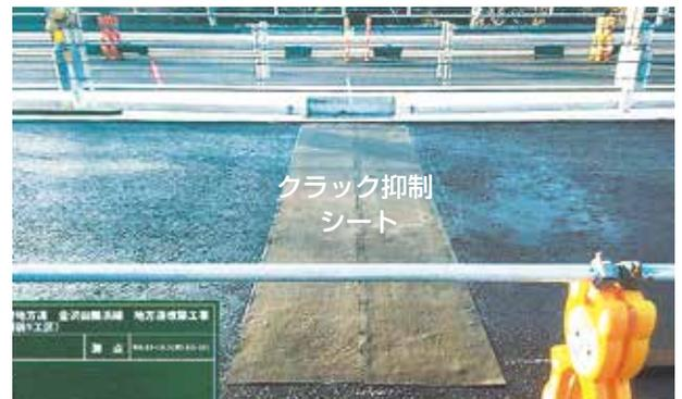
打継目のクラック抑制の工夫
